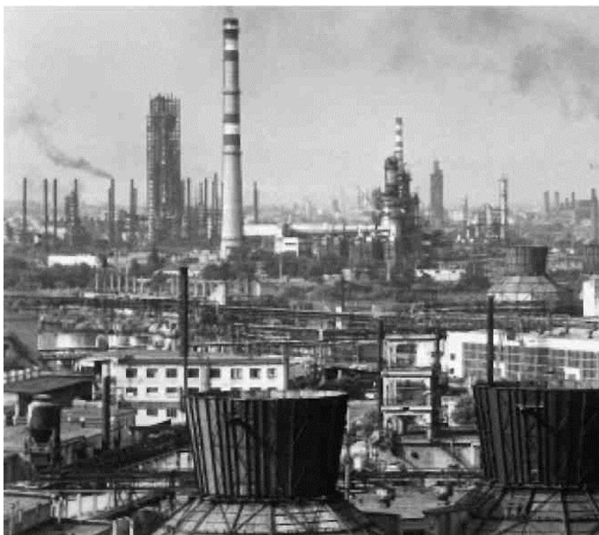
Грозненский нефтехимический комплекс. 1985 г. (Фото В. Щеколдина)
